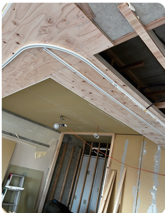
レール工事（下地序盤にバッチリ施工！）
